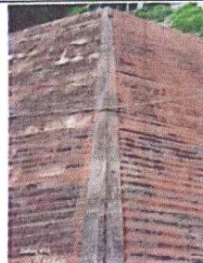
Foto 2: Sustrución de capote de lámina para lámina troquelada
