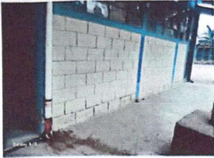
Foto 7: Pintura en muros exteriores e interiores
