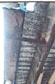
Foto 6: Sustrución de soporte o pescante de metal para canal
