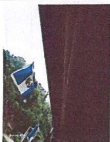
Foto 5: Sustrución de canal de metal por canal de PVC
