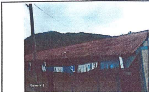
Foto 1: Sustrución de lámina, por lámina troquelada aluzinc calibre 26
