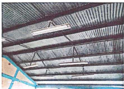
Foto 3: Mantenimiento a estructura de soporte de metal
